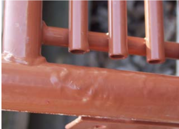
Abbildung 11: unverputzte Zinkverdickung
